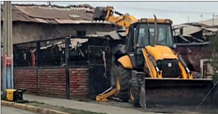
Con maquinaria pesada se trabajó en la recuperación de este espacio.
