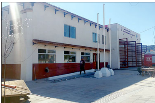
Desde otro ángulo, el nuevo cuartel de Bomberos de Curimón, en cuyo interior se cuenta con avanzada tecnología que incluye acceso con tarjeta.
