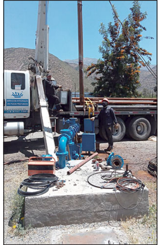
El lunes comenzaron los trabajos en el pozo del APR de Quebrada Herrera.
