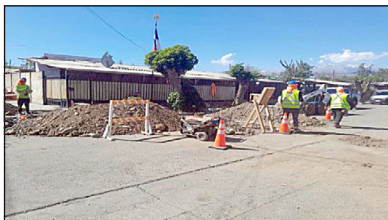
Las obras de mejoramiento beneficiarán a 950 hogares de la comuna y permitirán reforzar la continuidad del servicio.
