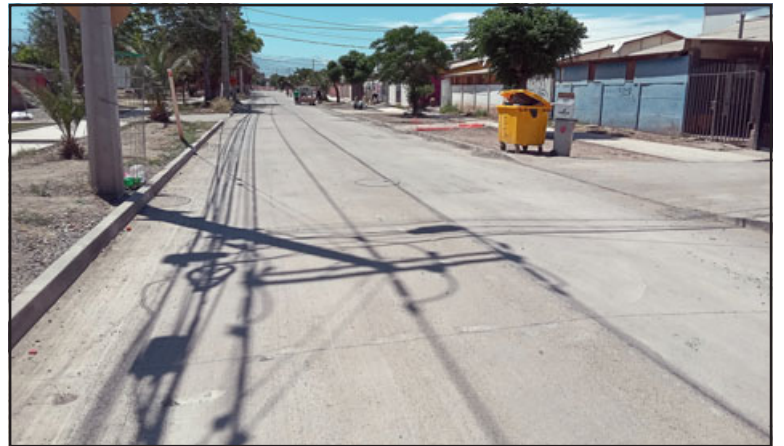
Así quedó la avenida Pedro de Valdivia.
