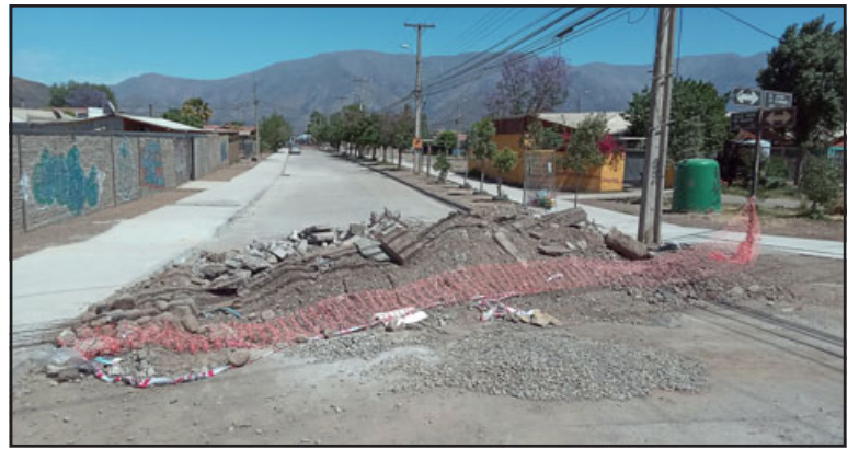
Este cierre es el que provoca malestar en algunos conductores, porque está hecho el trabajo. Eso sí, nos comentaron que faltaría pintar la señalética.
