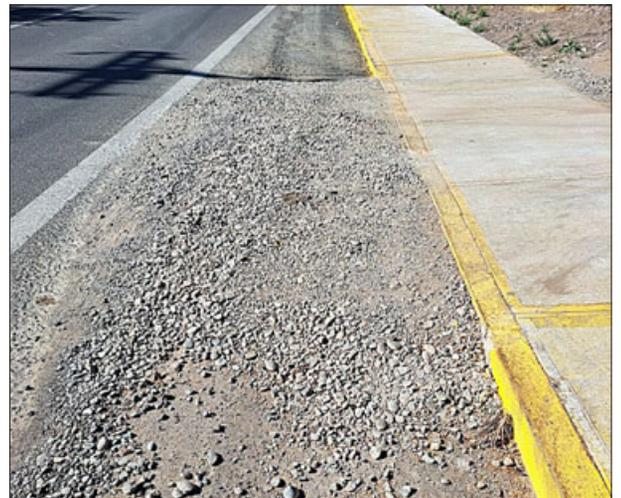
Acá se aprecia de más cerca el relleno instalado para que puedan subir los vehículos y el camión del agua.
