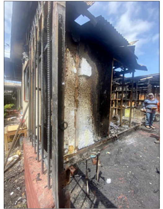
La parte sólida quedó en pie, pero lo demás fue todo destruido.
