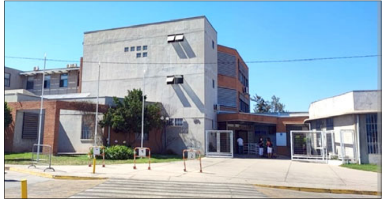
Proyectos del Cesfam de Curimón y SAR del Cesfam Segismundo Iturra se encuentran listos para ser licitados.
