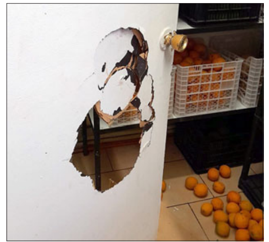
Este es el daño y destrucción que han generado en la escuela.
